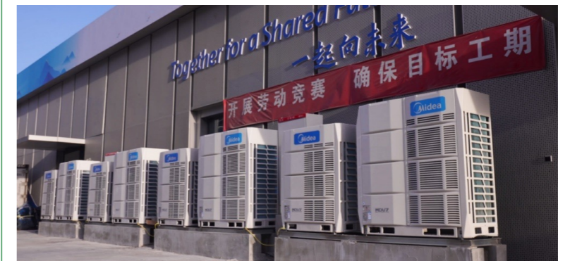
山地转播中心的美的 MDV 多联机（外机）
